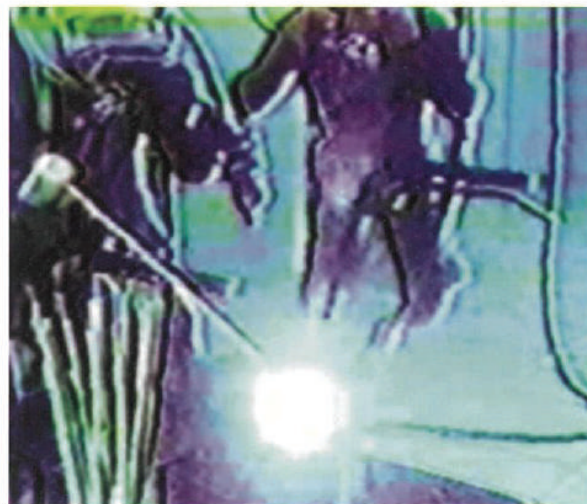
Under water weldomg 水中溶接
